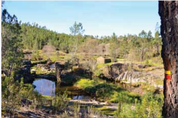
Ponte da Malhada do Cervo (Ponte Velha)
