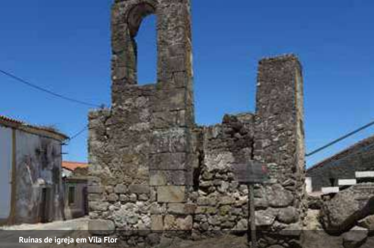
Ruínas de igreja em Vila Flor
