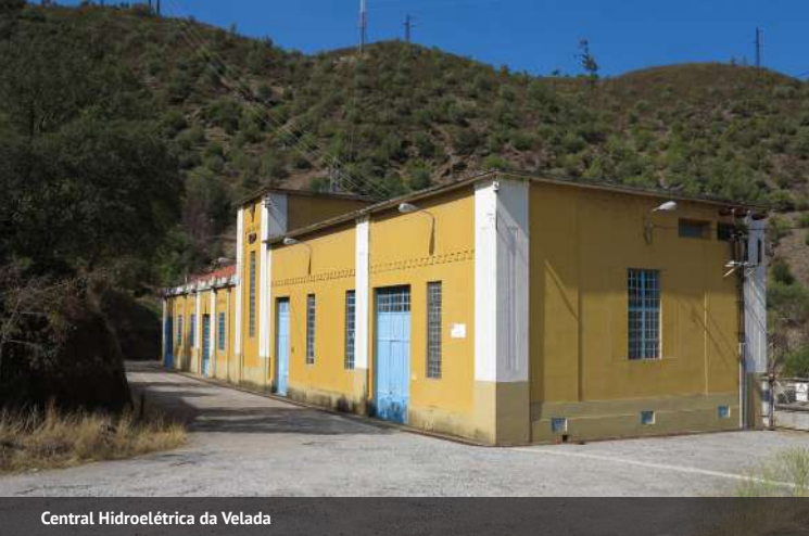
Central Hidroelétrica da Velada
